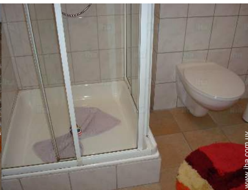
cuarto de baño
